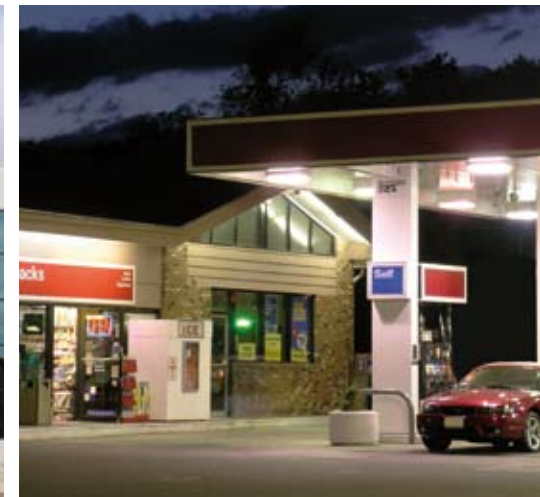
Bâtiments à usage commercial
